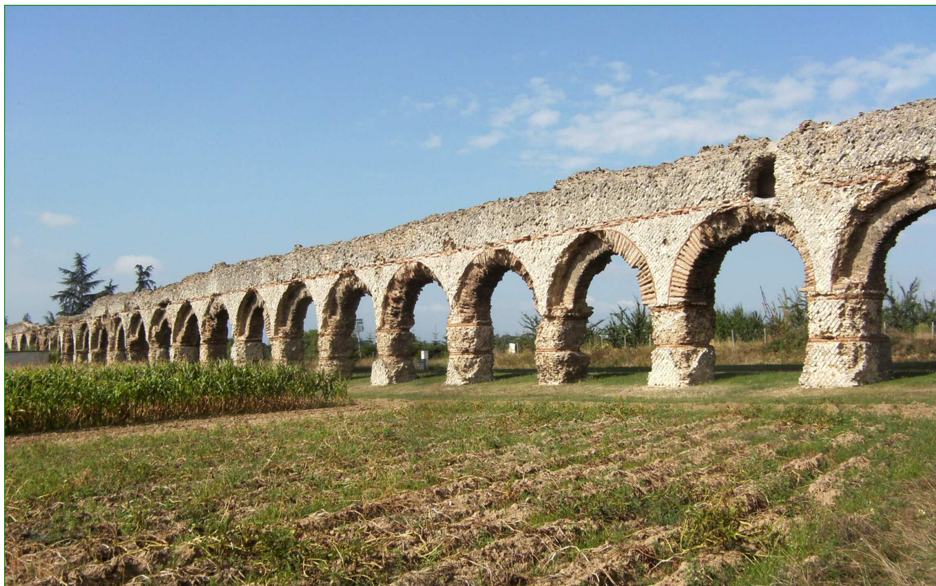
L'aqueduc du Gier
